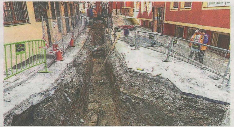
La zanja abierta en San Roque obliga a variar el tráfico en la zona. AVTO
