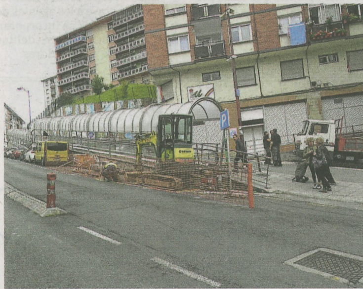
Las obras que se ejecutan en la cuesta durarán dos semanas. AYTO.
