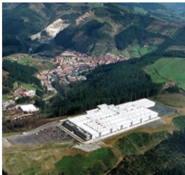
Obra de urbanización de Urtia
