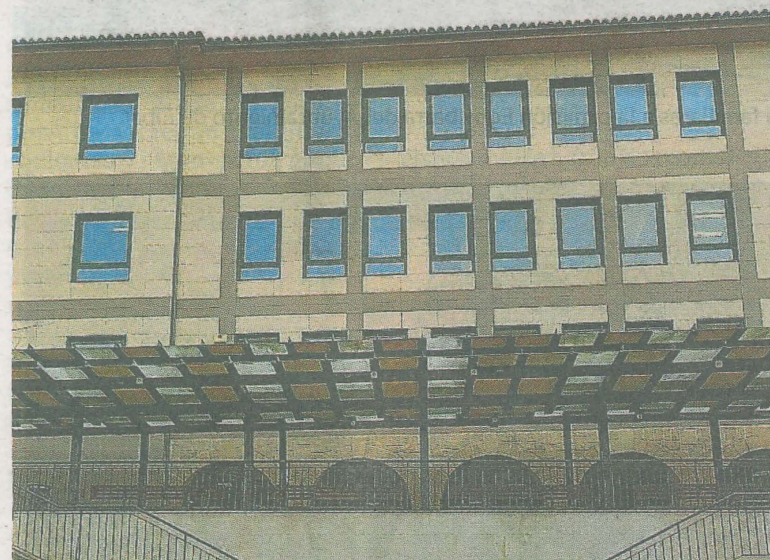
El servicio de biblioteca volverá a Teresa Murga tras instalar el mobiliario
